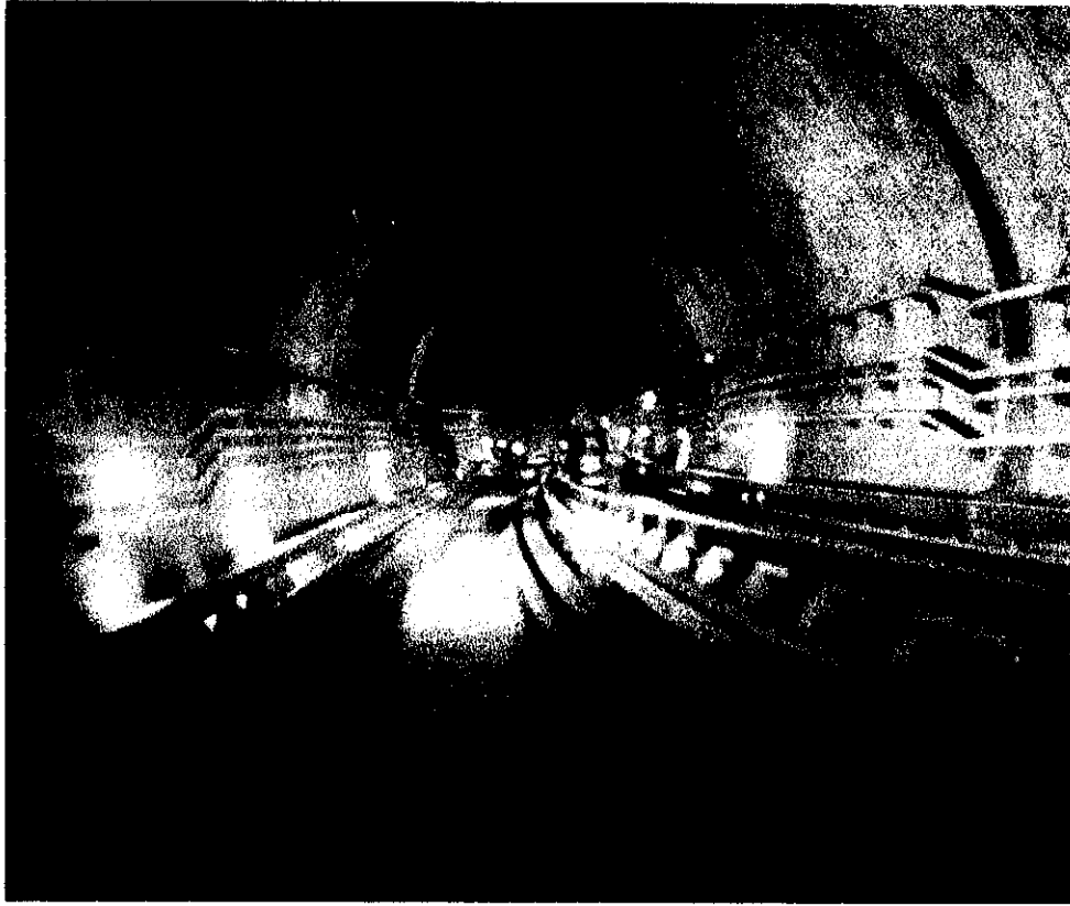
FOTO 5. Túnel de Auditorio a Tacubaya. Línea 7. Publicación: Un Metro de 108.5 kms , Covitur-DDF, 1985, pág. 6.
