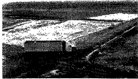
Ilustración 3 Rellenos Sanitarios Disposición final sobre geomembrana que evita filtración de líquidos contaminantes al subsuelo
