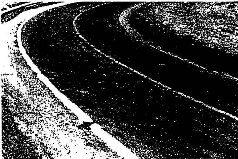
Foto 4. CORRUGACIONES EN UN PAVIMENTO ASFALTICO
