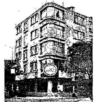
Edificios de departamentos Del estilo art decó en la Colonia Condesa
