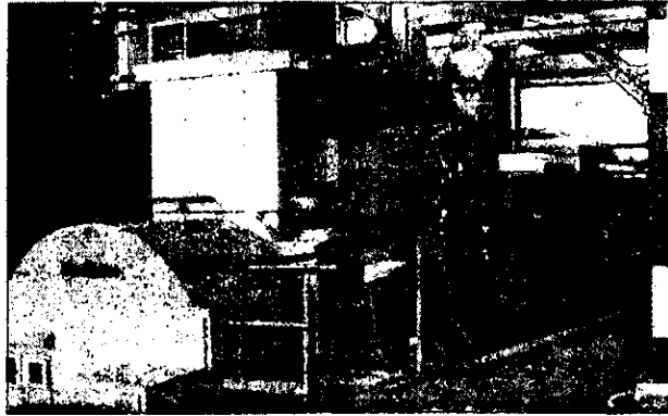
GENERADORES ELECTRICOS DE 60 Hz Y 3600 rpm TOTALMENTE CERRADOS Y ENFRIADOS CON HIDROGENO
