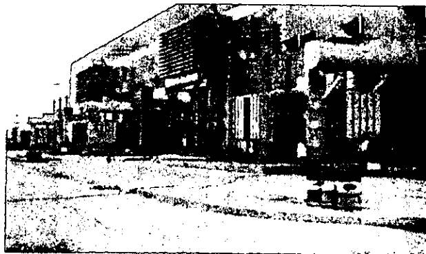
ARREGLO DE LOS TRANSFORMADORES EN LA PLANTA
