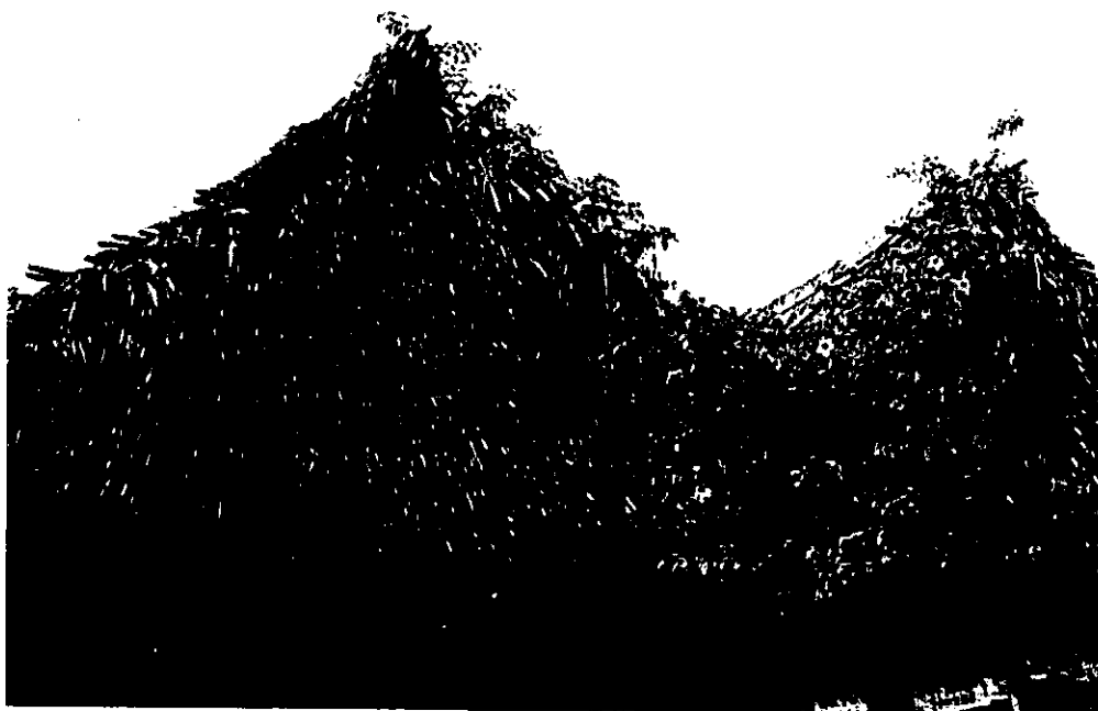
Gráfico 45. El ancho de la palapa está limitado a la extensión de los morillos. La Solución para ampliar el área cubierta es la palapa doble o cuata. Barra de Navidad Jalisco.
