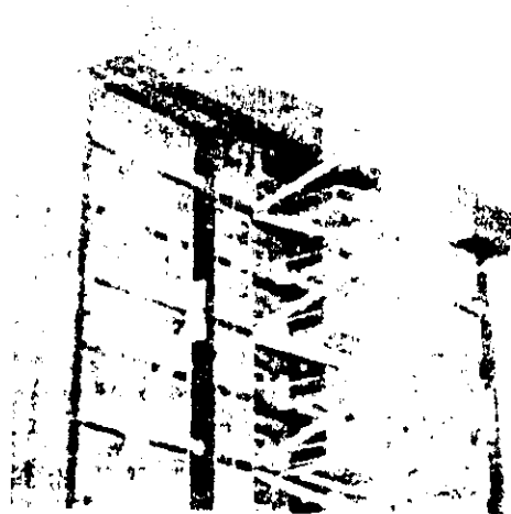
Se aprecia la integración estética entre el edificio y las escaleras de emergencia, además, de una distancia adecuada tomando en cuenta que hay cristal en los muros de los costados (Vista posterior del hospital). Escaleras de emergencia del Hospital del ISSSTE 20 de Noviembre en la Ciudad de México.
