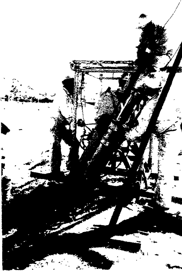
Figura V.2. Sitio de muestreo y maquinaria de perforación
