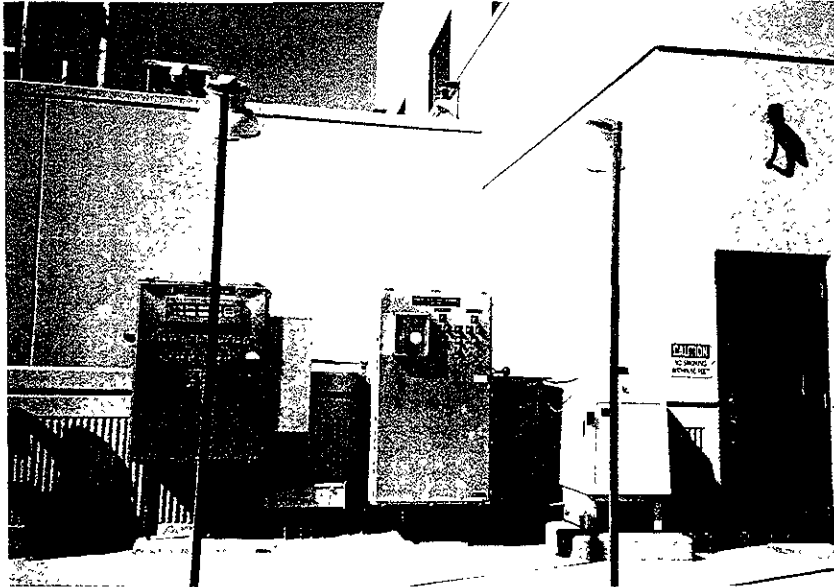
Fig 3.5. Muestreador automático en la planta de tratamiento de agua residual en San Diego, Cal.
