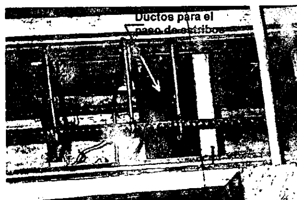
c) Detalle de cimbra y armado de viga longitudinal típica
