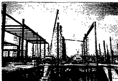
MONTAJE DE ESTRUCTURA METALICA, UTILIZANDO GRUAS HIDRAULICAS
