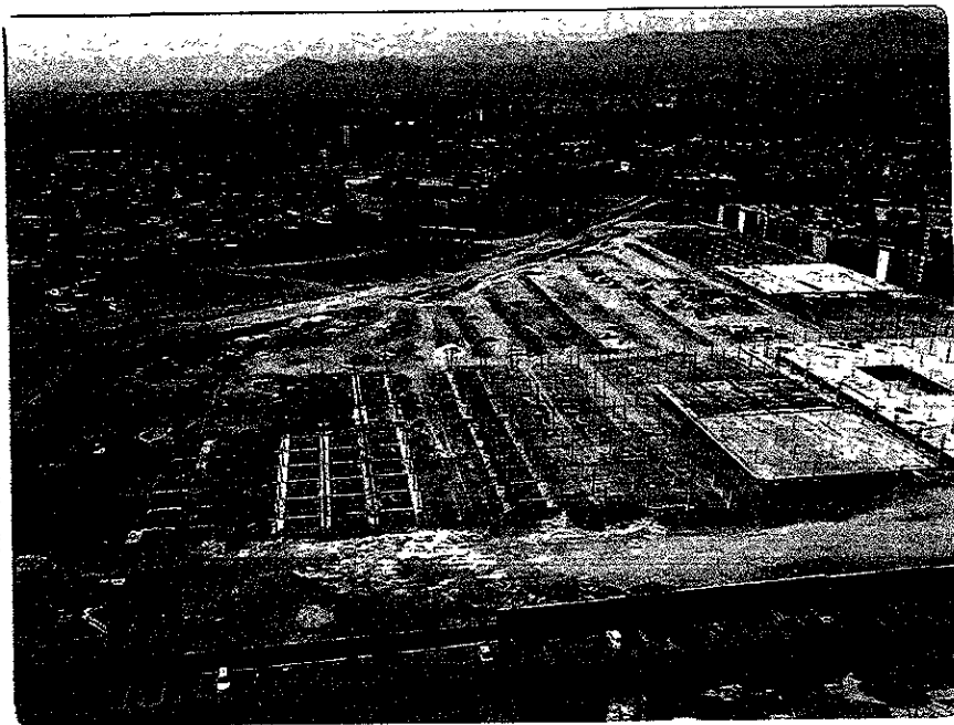
CIMENTACION, COLUMNAS DE CARGA Y LOSAS DE ENTREPISO
