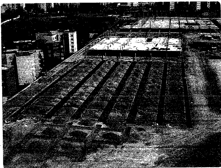
EXCAVACION Y COLOCACION DE ACERO DE REFUERZO EN CIMENTACION
