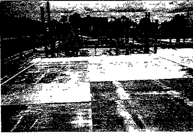
COLOCACION DE CIMBRA EN LOSA
