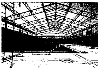
MONTAJE DE ARMADURAS DE ACERO, PARA COLOCACION DE DOMO
