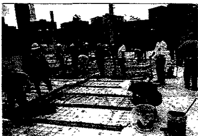
COLOCACION DE CONCRETO BOMBEADO EN LOSA Y TRABE
