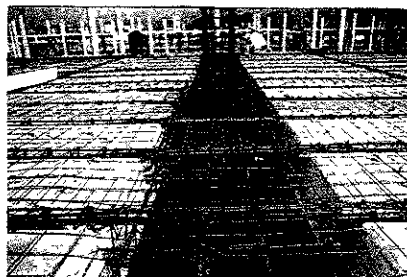
COLOCACION DE ACERO EN TRABE
