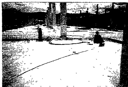
APLICACIÓN DE TENSADO A ESTRUCTURA
