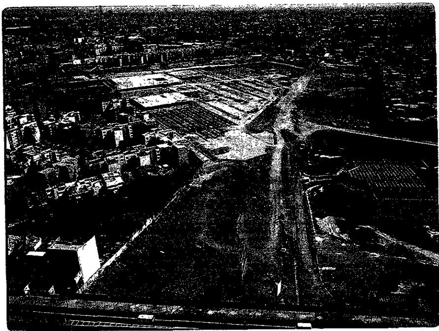
PROCESO DE CONSTRUCCION DE VIALIDAD, ACCESO SOBRE PERIFERICO
