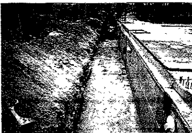
RELLENO Y COMPACTACION EN MUROS EXPANCRET AREA DE ESTACIONAMIENTO
