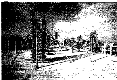
CIMBRA EN COLUMNAS PRIMER NIVEL
