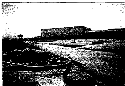
PAVIMENTACION DE VIALIDAD
