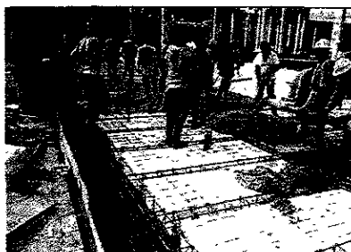
COLOCACION DE CONCRETO BOMBEADO EN LOSA Y TRABE
