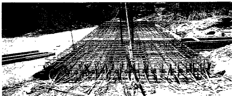
ACERO DE REFUERZO EN CIMENTACION
