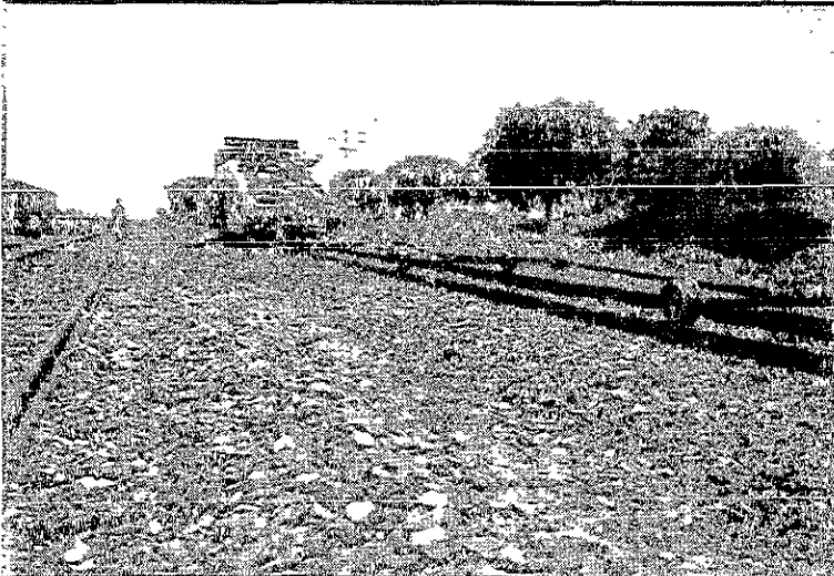
ALINEACIÓN DE LA VÍA
