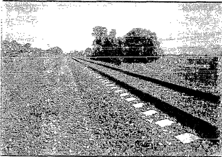
ASPECTO FINAL DE VÍA REHABILITADA
