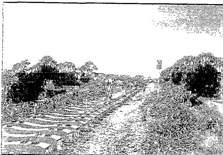
COLOCACIÓN DE DURMIENTE MONOLÍTICO DE CONCRETO PRESFORZADO Y PREESPACIAMIENTO DE LOS MISMOS
