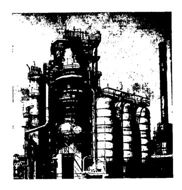
Esta planta catalítica opera con temperaturas del orden de los 480 y 540°C y con presiones que alcanzan en algunas partes del proceso hasta los 30 Kg/cm² por lo que podemos considerar a esta planta como una instalación de alto riesgo.
