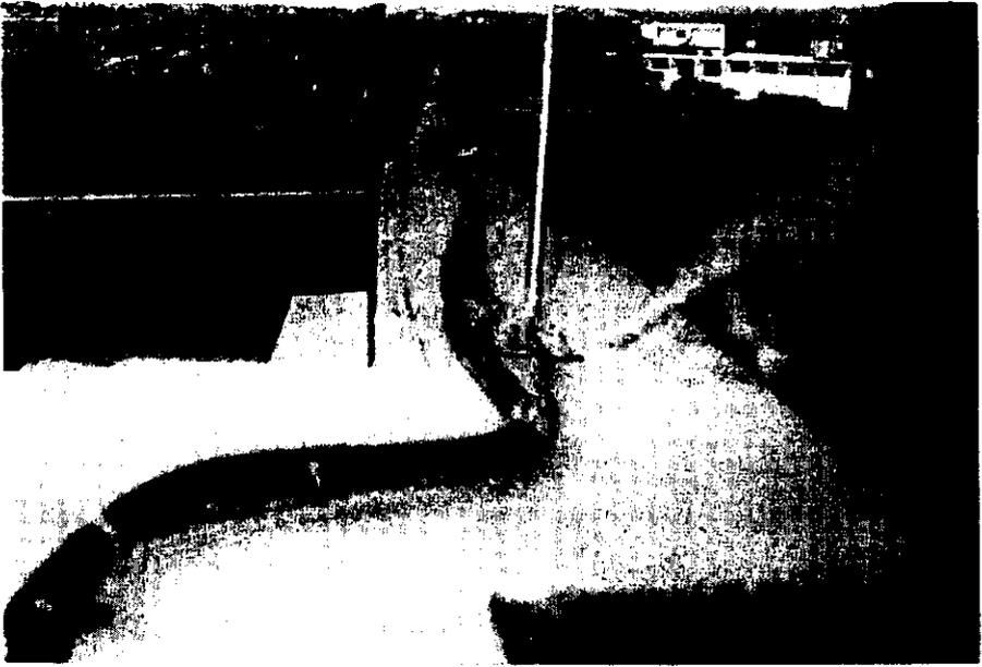
Incorrecta colocación de cable de comunicaciones, cerca del cable de pararrayos.
