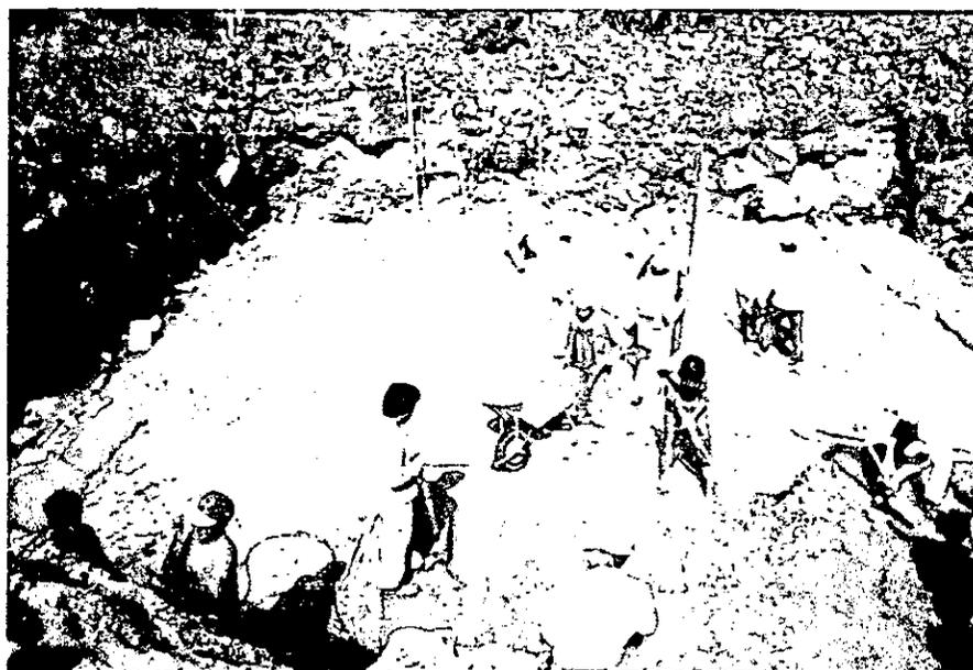
Figura 5.7 Colocación de la malla geotextil y la plantilla de concreto pobre para desplante de la subestructura.
