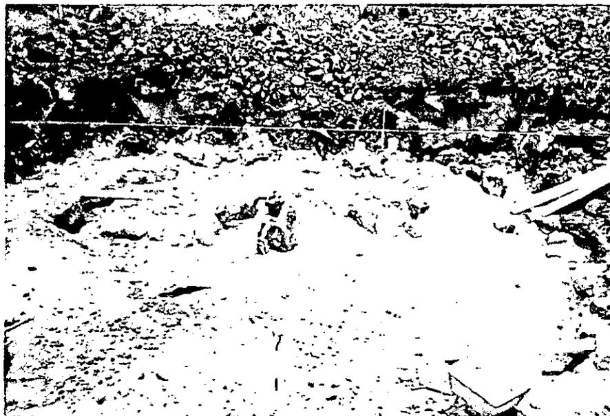
Figura 5.6 Relleno con tepetate compactado al 90% Proctor.
