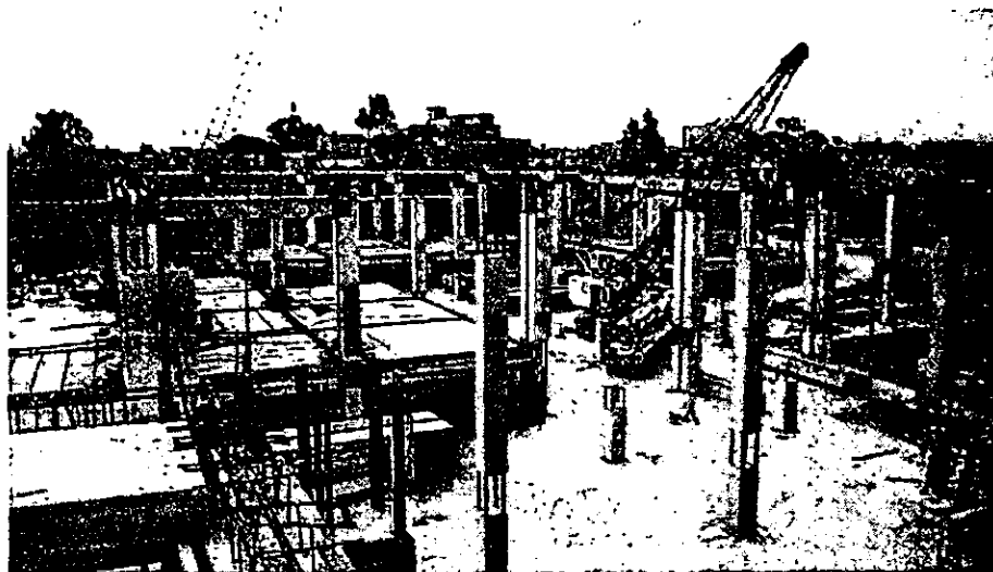
Figura 5.22 Vista parcial de la estructura prefabricada en la construcción del Hipermercado Auchan.
