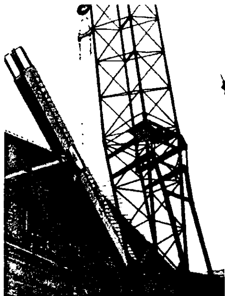
Figura 5.16 Izado de columna prefabricada.
