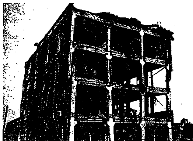
Figura 3.9 Vista general de un edificio industrial a base de marcos de concreto prefabricado después del sismo, Leninakan, Armenia.
