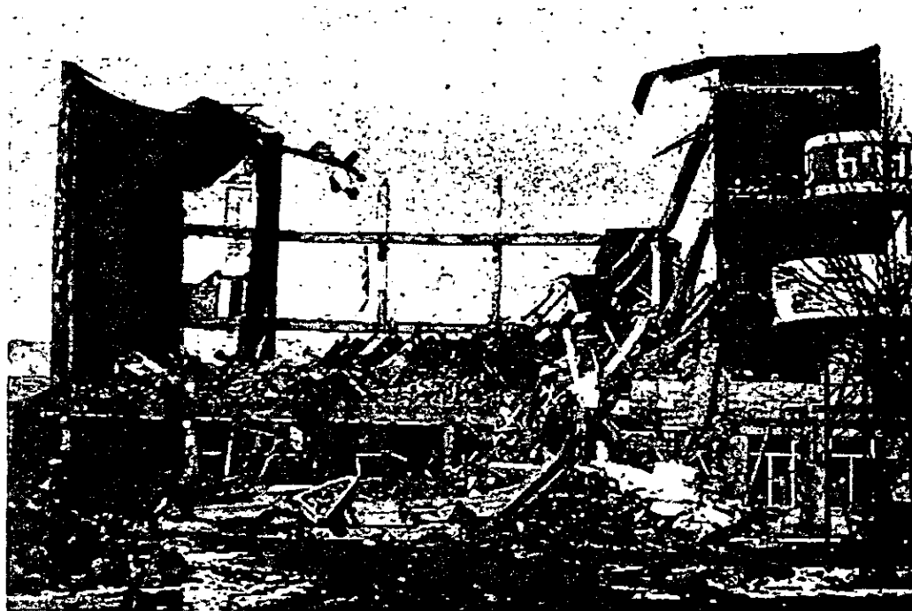
Figura 3.7 Daños en un edificio de cinco niveles por conexiones inadecuadas entre el sistema de piso y los marcos, Leninakan, Armenia.
