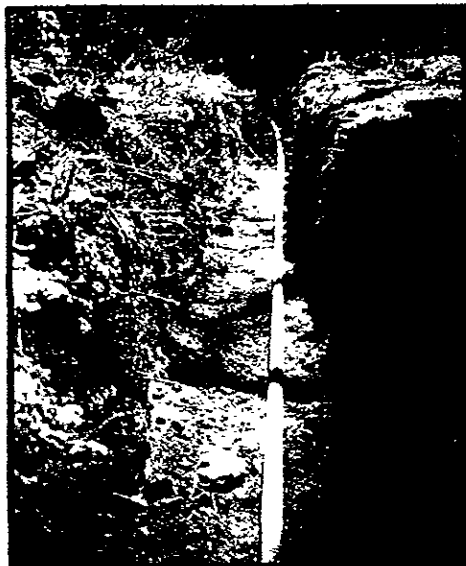
Fig. 4.19. Tendido y sellado de la tubería de alimentación del influente del río a la fosa séptica por bombeo.
