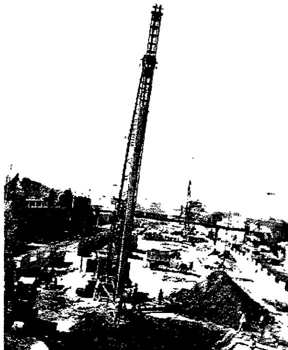
Fig. IV.2.2.2 Pilotes de concreto reforzado
