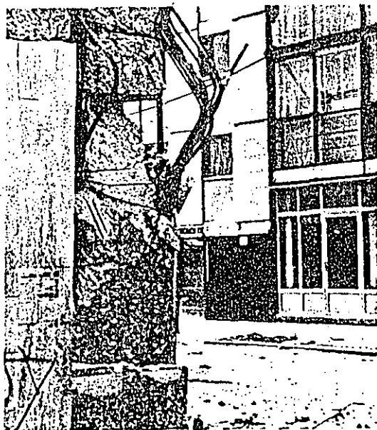
FALLA DE PAQUETE DE VARILLAS EN COLUMNAS
