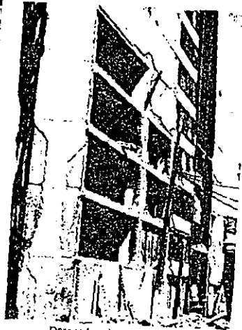
Derrumbe de muros de relleno de mampostería.
