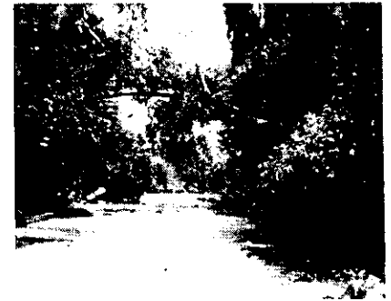
Canal totalmente azolvado nula circulación del agua y agua contaminada en altos niveles.
