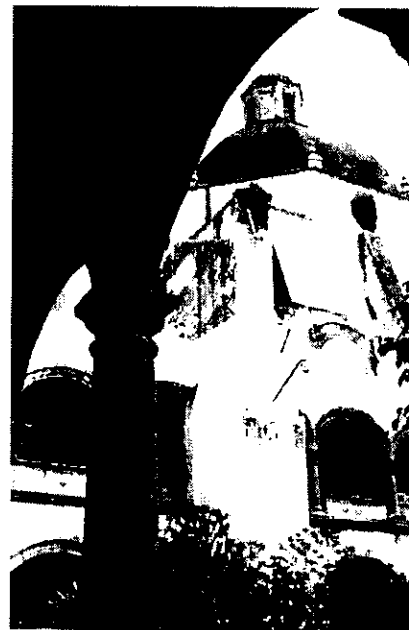
Abandono del patrimonio histórico además del patrimonio natural.
