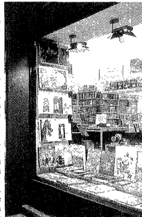
Lamparas Tecno III. -s, con capacidad para una luminaria de Tungsteno Halógeno de 300 watts
