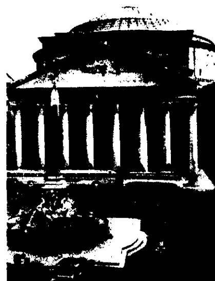
El Panteón en Roma. Erigido después de 126 por Adriano, la construcción circular consta de un colado con revestimiento de ladrillo, al vestíbulo lo sostienen columnas de granito. Fig. 2.16
