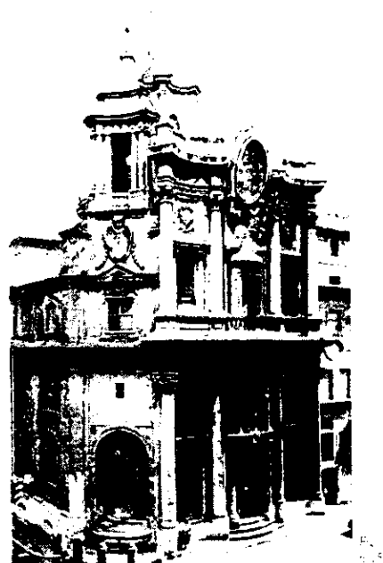
Fachada principal de San Carlo alle Quattro Fontane, diseñada por Borromini en Roma.
