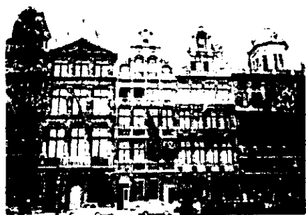
Casas de la Gran Plaza de Bruselas, construidas a finales del s. XVII.
