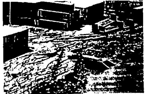
Figura 1.12, y 1.13 Deformación lateral en zonas no confinadas y bolas De arcilla expulsadas por los chorros de arena (Ovando E. 1995)
