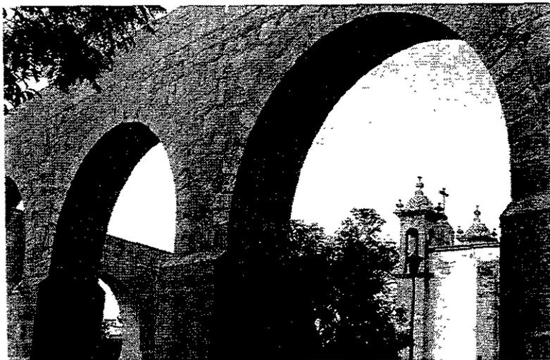
La construcción del Acueducto fué iniciada en el año 1785, concluyéndose cuatro años después / Tiene una extensión de 8.6 km con una arcueta de 253 elementos con altura de 4.89 m y ancho de 7.47 m
