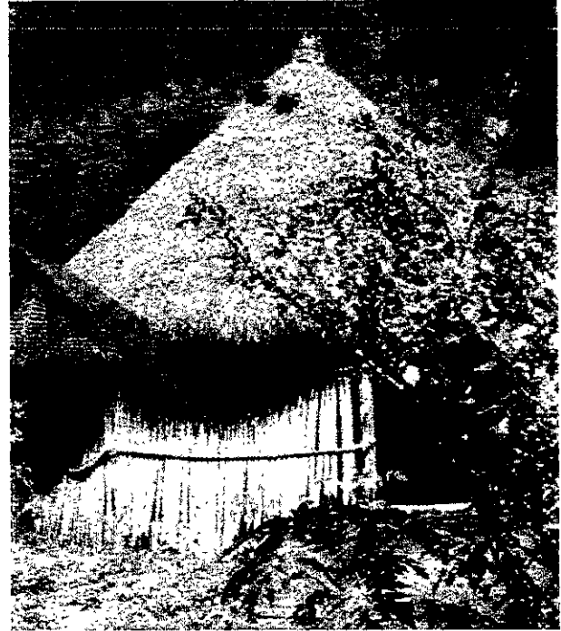
Techos de palma y paredes de carrizo
