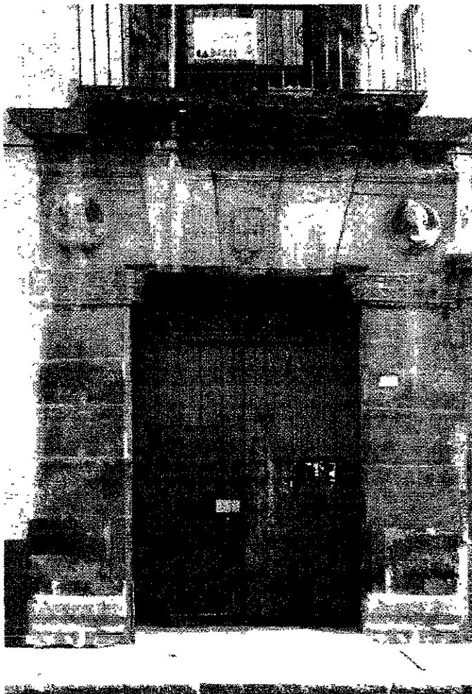
Entrada principal, con enmarcamiento de piedra resaltando dos cabezas de piedra en relieve en la parte superior.
