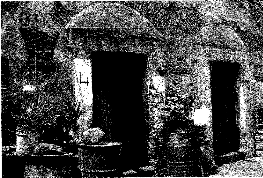
Fachada interior de una vivienda en el barrio de La Luz
