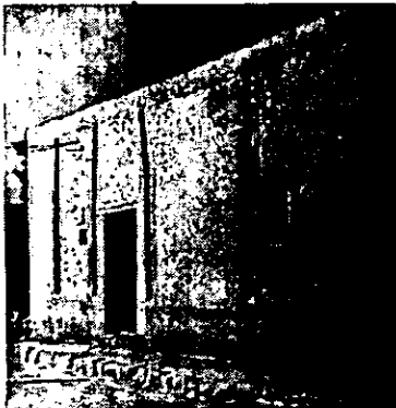
Fig. 61 Casa típica en Chihuahua con una fisonomía similar a la del convento de Casas Grandes. (fuente: "Vivienda Campesina en México..." Prieto Valeria)
