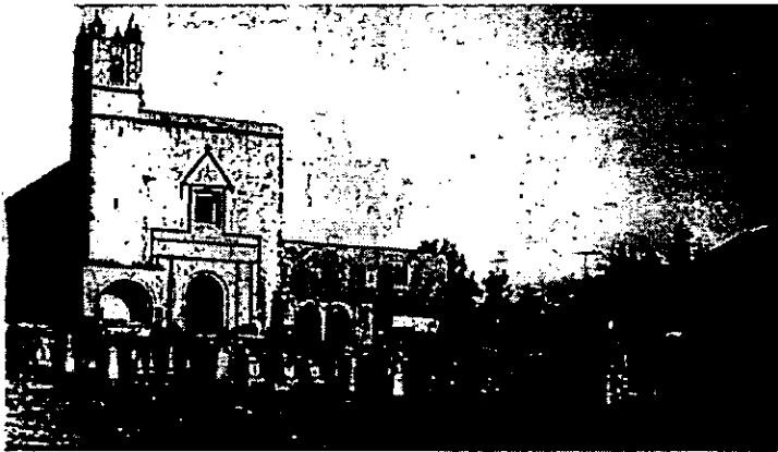
Fig 71 Fachada del Exconvento de Epazoyucan en Hidalgo, donde se nota la escasez de ventanas y un tamaño reducido de las mismas. (fuente: "Conventos del sXVI en el Estado de Hidalgo"...)
