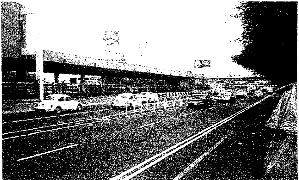
Postes de señalamiento existentes al inicio del mismo murete.
