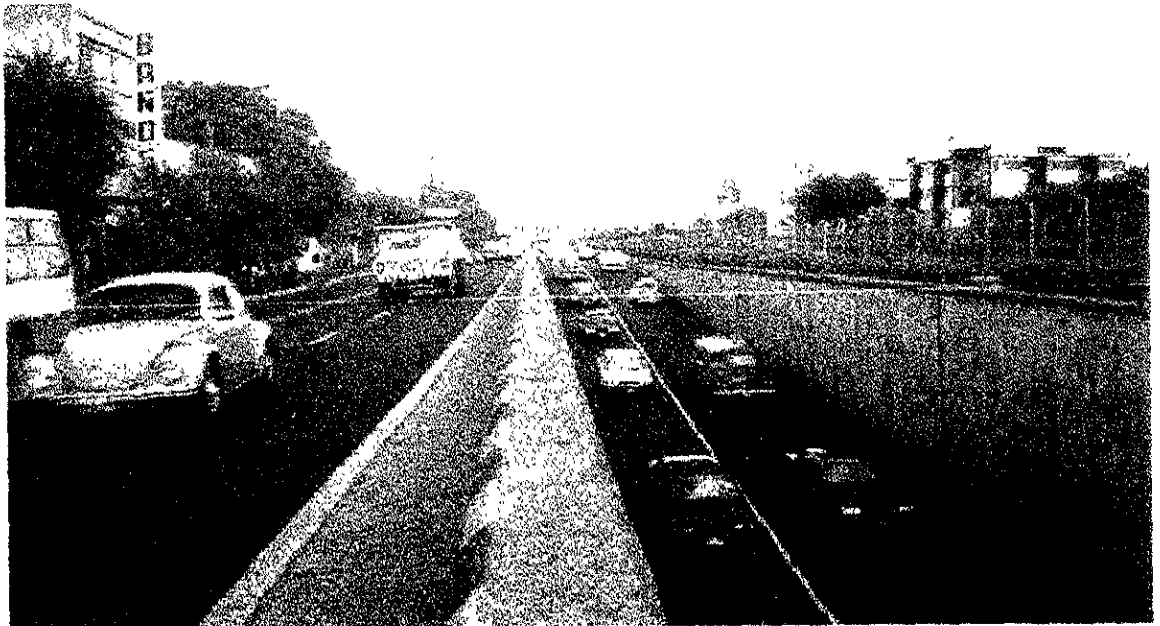
Vista del murete existente en el tramo entre Municipio Libre y Emiliano Zapata.
