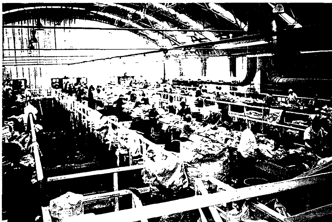
Planta de Selección de Reciclados de San Juan de Aragón: En la foto superior la consola de control de las bandas de las líneas de producción (marcha y velocidad), abajo las líneas de producción en operación.
