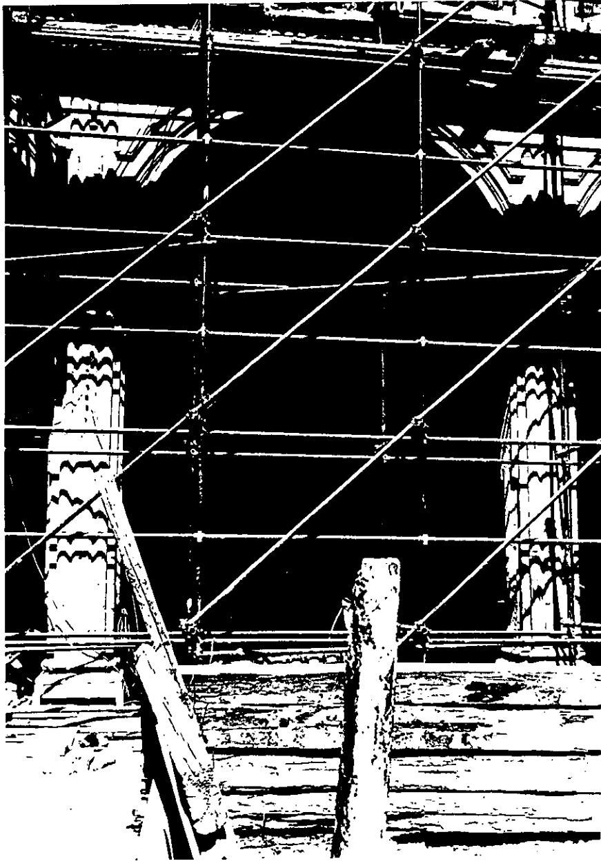
Arco de medio punto sobre pilastras del primer cuerpo del Hospital Real de Nuestra Señora de Belén y San Francisco Xavier. Restauración a cargo del Banco de México. Fotografía de Esther Tovar Estrada (1998).
