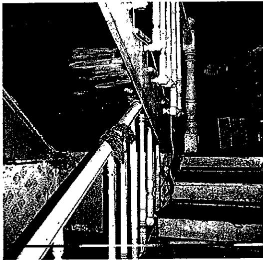
**Fig. 146 y 147 – Deterioros en la escalera de madera (Escalones, barandal y plafón).
