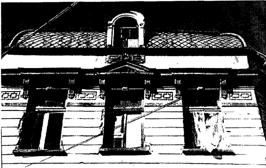
**Fig. 155 – Recubrimiento de la vertiente convexa (brisis) de la mansarada, de teja de asbesto, colocada a la francesa.**
