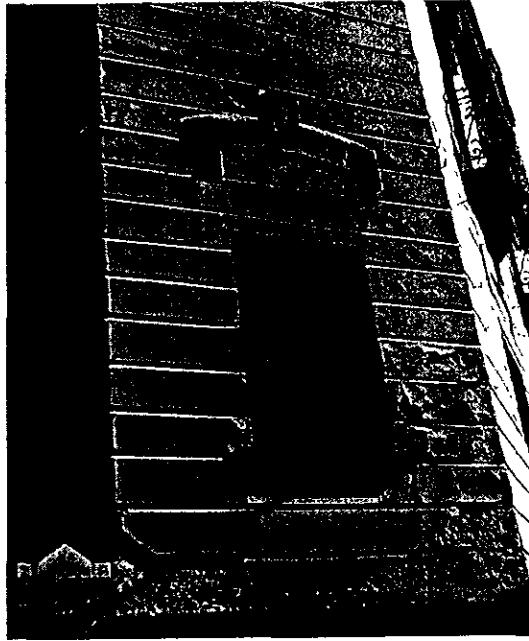
**Fig. 154 – Deterioro en aplanados de fachada de entrecalles horizontales (muy usado en el barroco francés) y tapiado parcial de algunas ventanas.**
