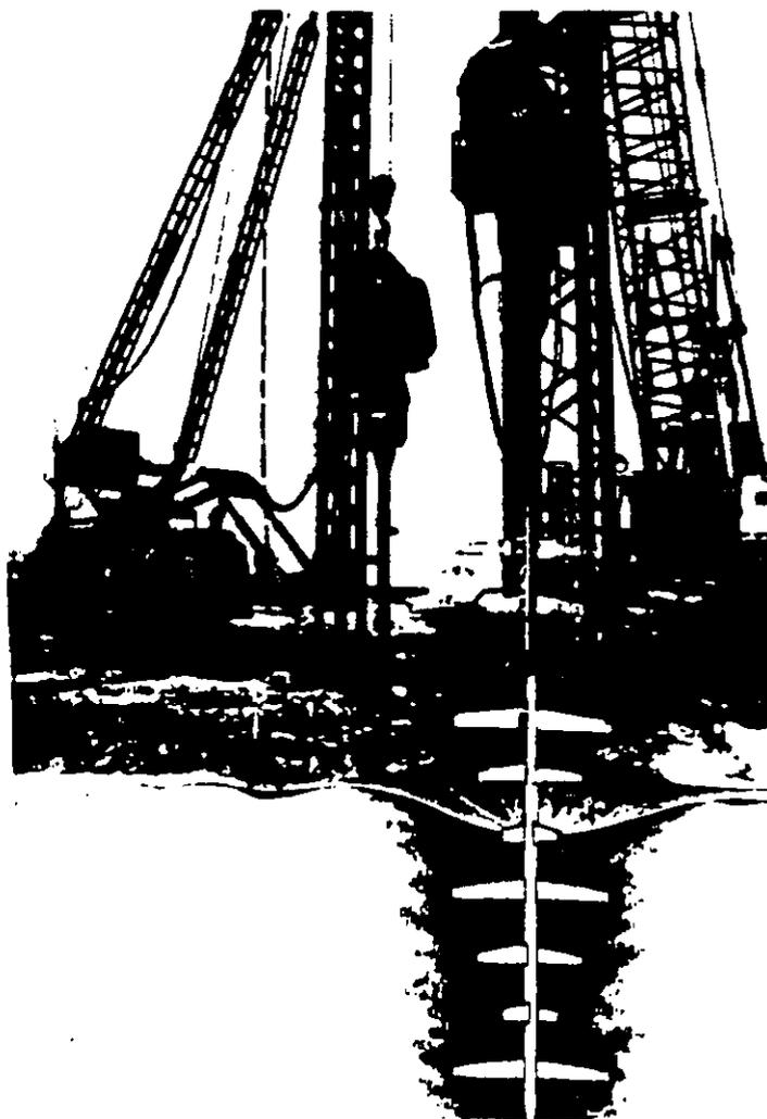
Fig. 3.23 Sistema Sueco *Vibro Wing* (Massarsch, 1991)
