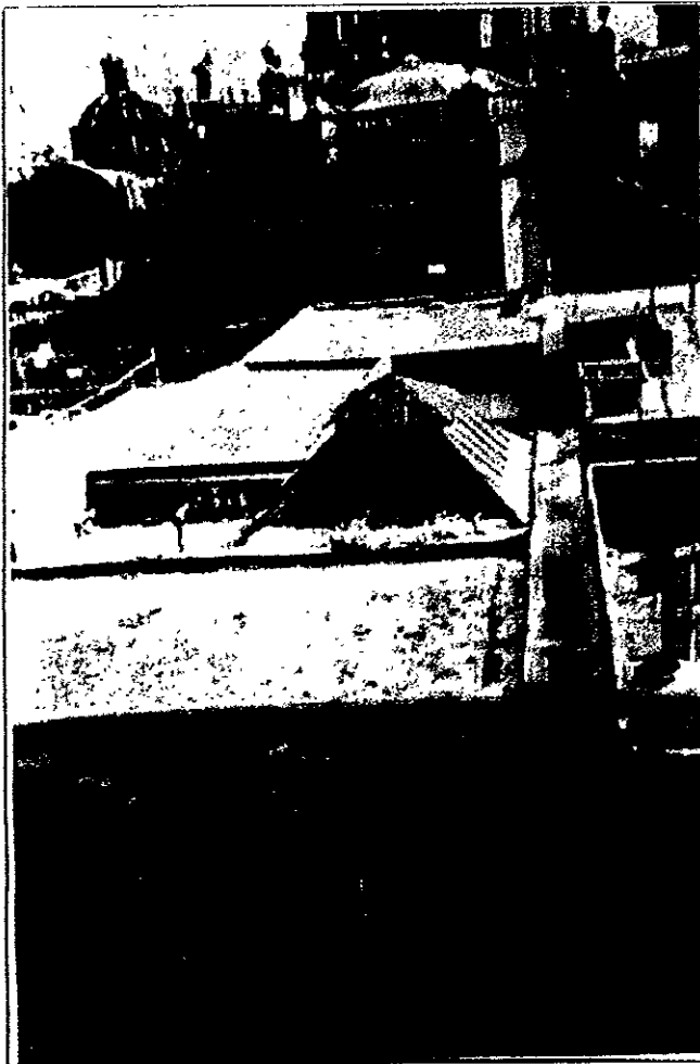
FOTO EN LA QUE SE APRECIA AUN LA CUBIERTA DE LAS ESCALERAS PRINCIPALES.
