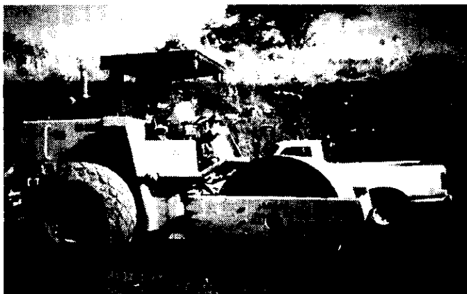
Foto 4.14 Compactación de capa subyacente con Vibrocompactador
