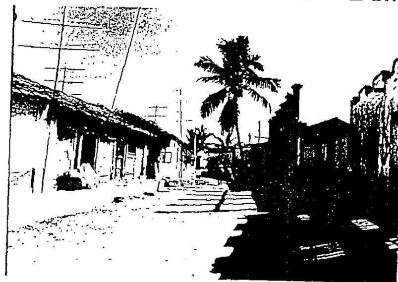
UN ACCESO A LA ISLA (ARRIBA). SE PUEDE OBSERVAR LA TIPOLOGIA CLASICA: MUROS DE BAJAREQUE CON ARCILLA RECUBIERTOS CON CAL, TECHUMBRES CON ESTRUCTURA DE MADERA CUBIERTOS CON TEJA ASI COMO UN SOLO VANO O PUERTA DE ACCESO EN LA FACHADA PRINCIPAL.
