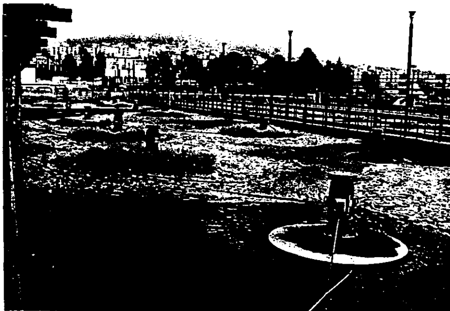
FIG. 4 Aireadores mecánicos superficiales de alta velocidad en funcionamiento.
