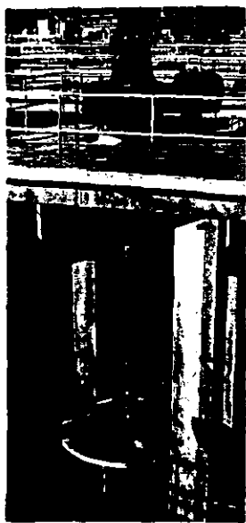
FIG. 3 Aireador mecánico sumergido de eje vertical.
