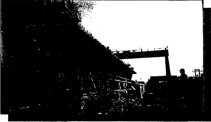
Retiro de trabe prefabricada del molde metálico mediante
