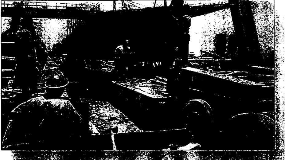
Colocación de trabe prefabricada en tracto-camion
