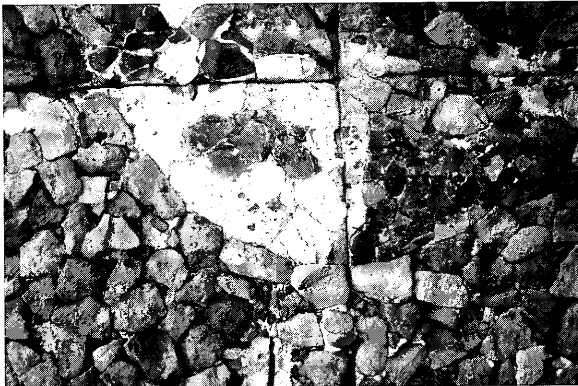
Figura 36. Ejemplo de daños del mural, caída de piedras.
