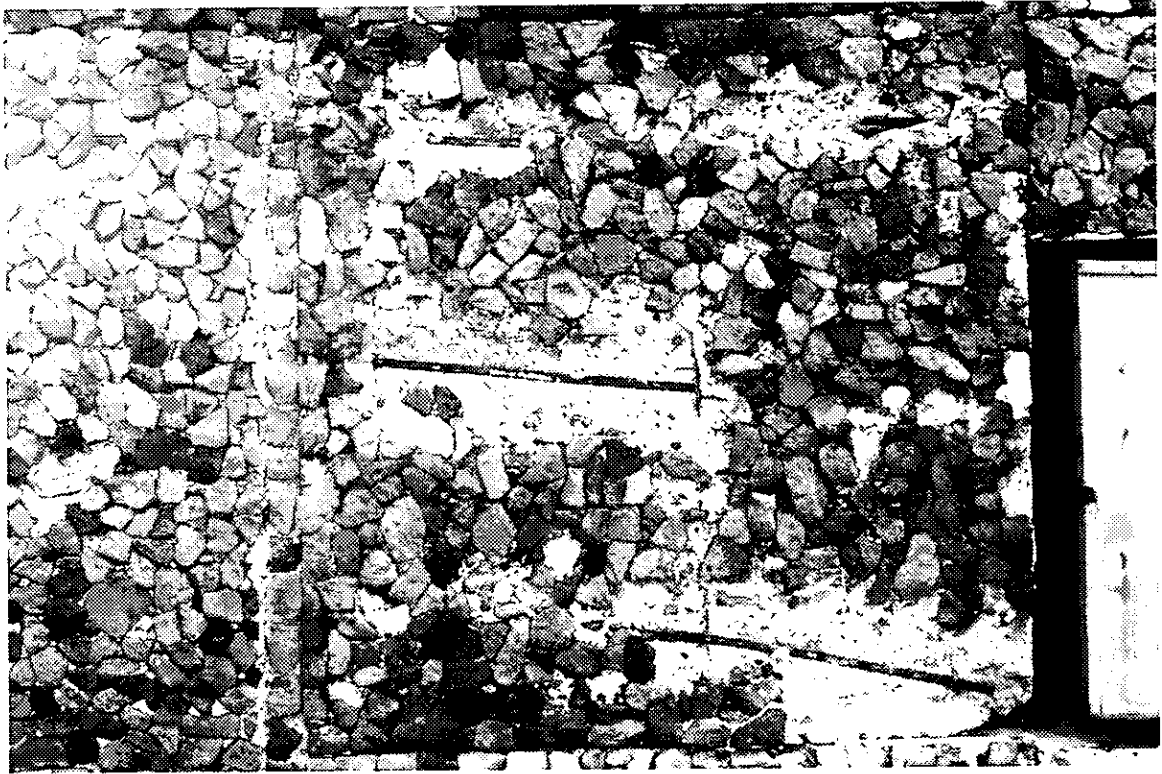
Figura 38. Ejemplo de daños del mural, estallamiento de placas.
