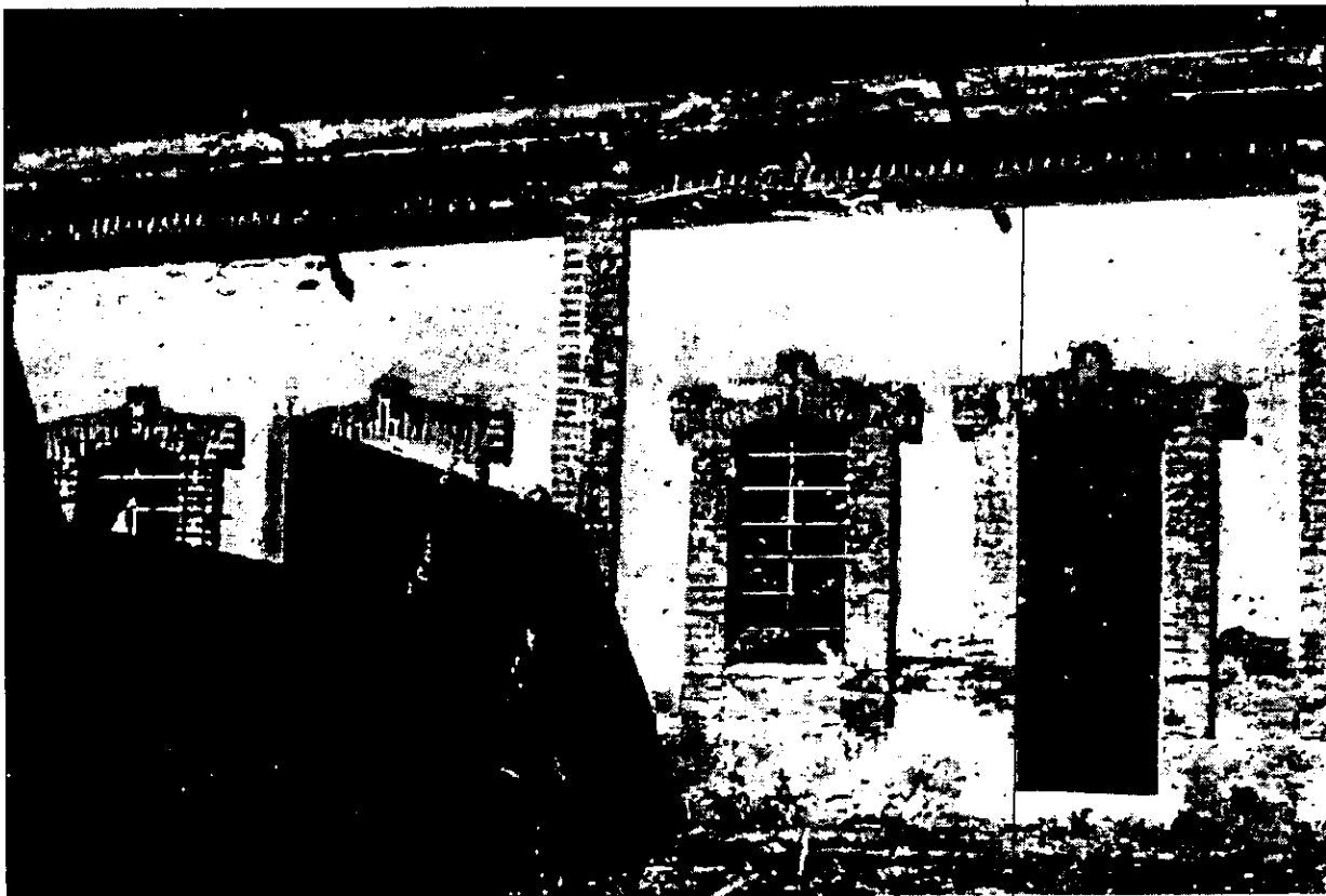
Figura 37. El pretil se encuentra formado por un aparejo en tabique aparente de la región, que tiene como base dos hiladas a tizón, una sobresale más que la otra, continúa con una hilada triscada vertical y tres hiladas a tizón sobre ésta, para formar el remate del pretil se continúan con hiladas a soga, que sirven para detener el agua y encaminarla hacia la "yarda" de tubo de lámina de 4" que sirve como desagüe.
