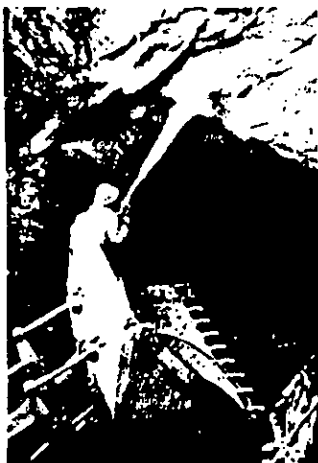
Fig. 11 El éxito de un operación de concreto lanzado depende esencialmente de la habilidad del operador y de la boquilla.
