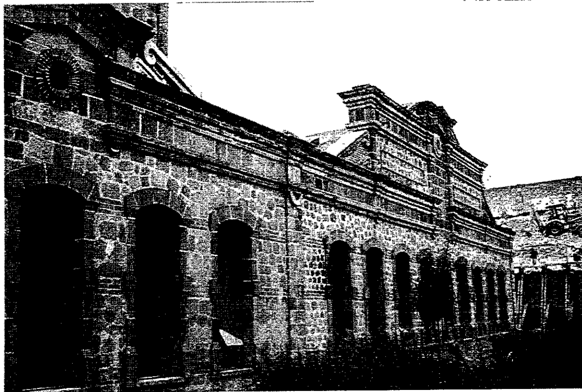
FACHADA SUR DEL AREA DE TELARES, LA TRINIDAD TLAXCALA. ILUSTRACION IV
