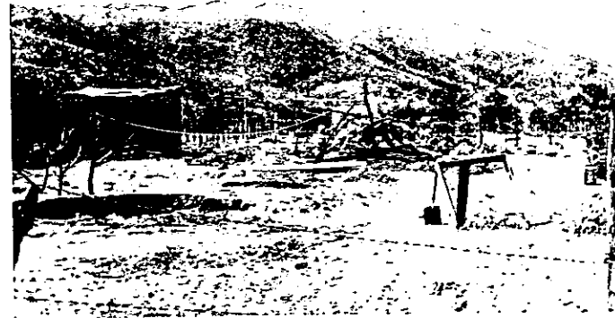
2 VISTA AL ESTE.- TERRENO LIBRE SIN CONSTRUCCIÓN.
