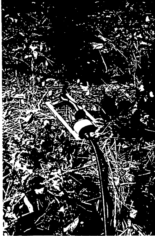
Sistema de Riego (Aspersión)
