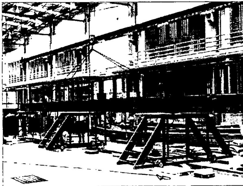
*Foto 3.3 Colocación de la estructura a su nivel de proyecto.*
