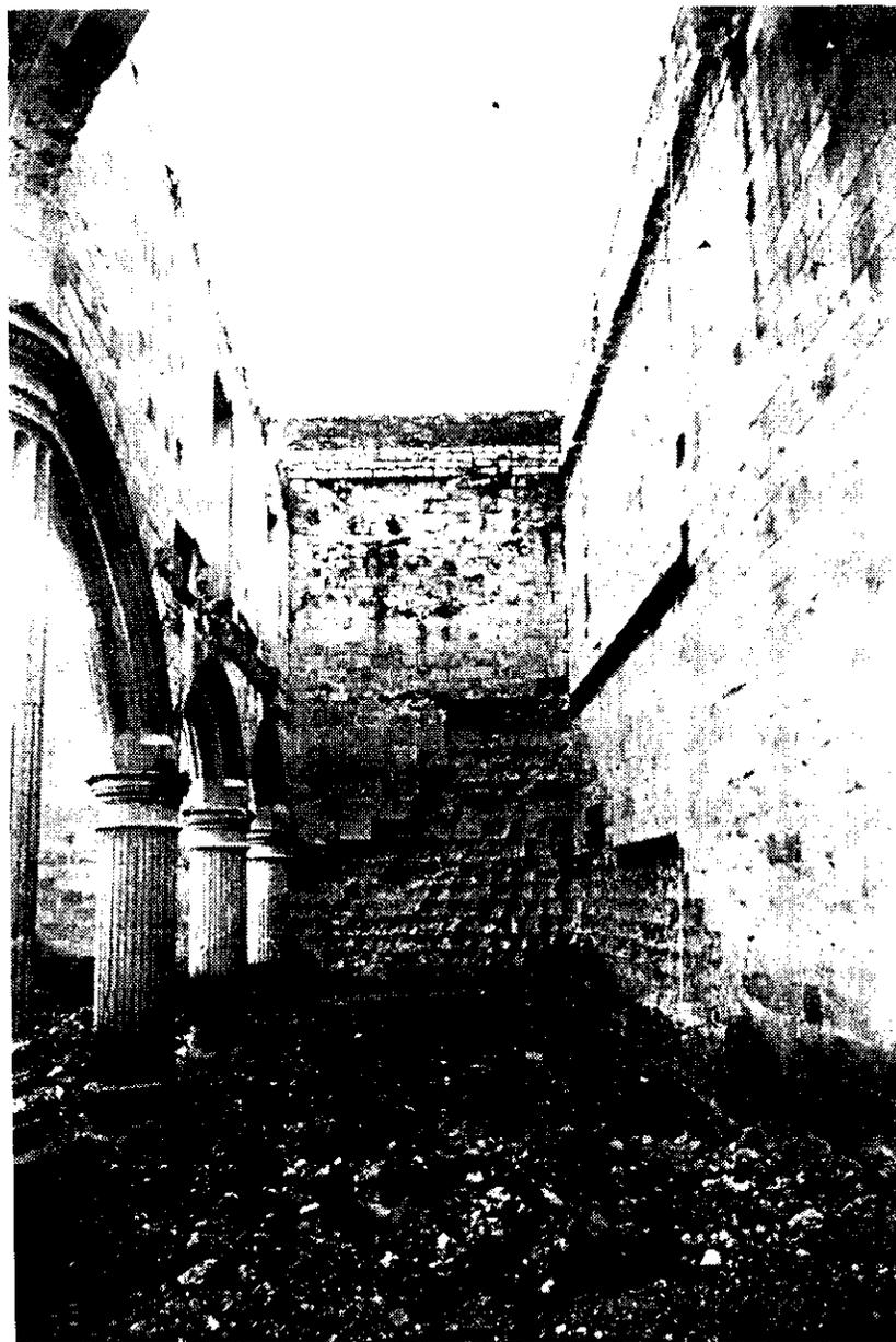
FIG. 91. Fotografía que muestra la pérdida de las cubiertas planas (archivo fotográfico INAH).
