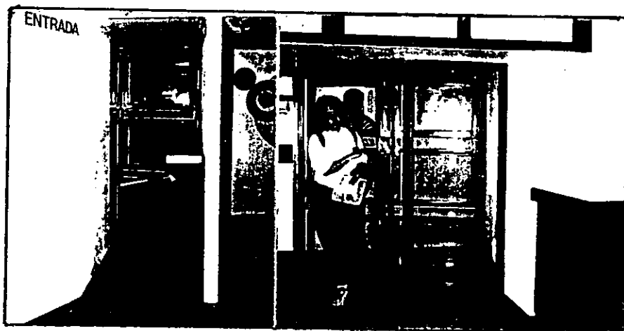
Entrada de la biblioteca, el giro de noventa grados que se realiza al pasar el torniquete es una condición insegura para el usuario, que continuamente se golpea con el cristal.
