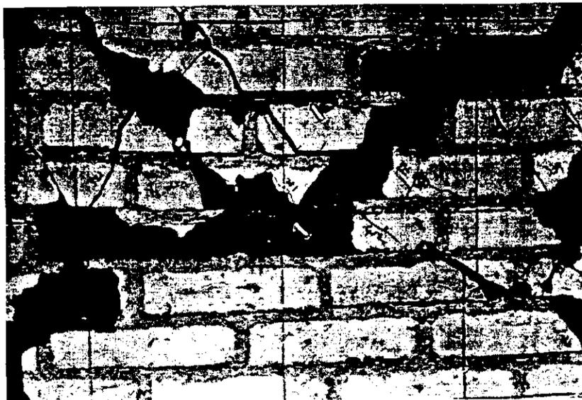
*Fig 3.6 Detalles de fracturas de escalerilla*
