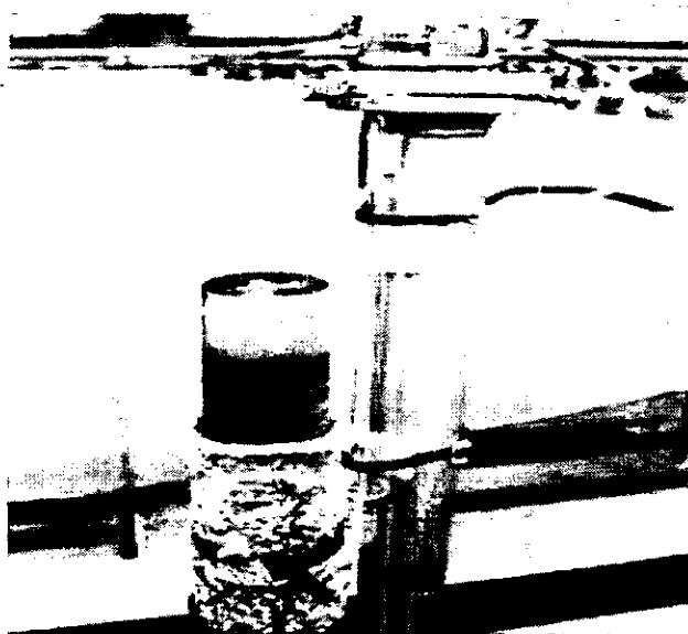
Figura 2.1 Diagrama de instalación del sistema de inyección que consiste en: una bomba recíproca (ubicada en la parte más alta del dibujo) que sirve para suministrar aire al depósito de amoníaco (tubo de vidrio transparente); válvula de regulación de suministro de \text{NH}_3 hacia los gases de combustión y chimenea.
