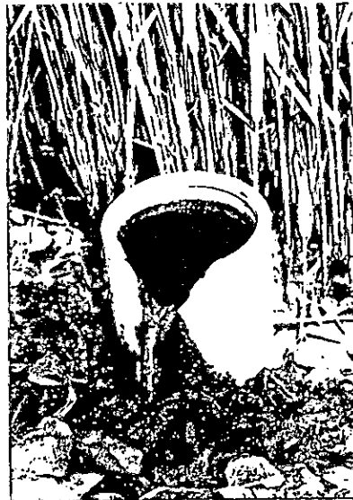
Figura 2.8. Tubería de distribución colocada en forma vertical en un HAFH (Reed, 1992)
