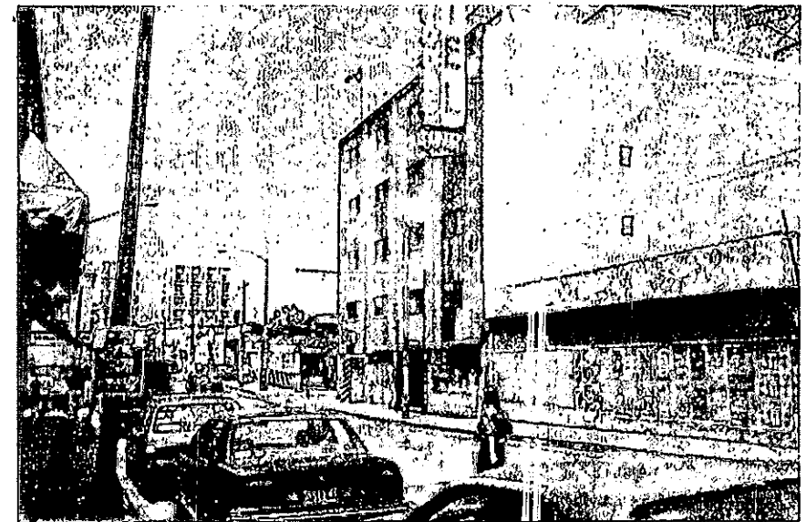
Ilustración 12 Debido a la cercanía con el centro histórico y lugares de recreación nocturna surgen construcciones necesarias para el hospedaje.
