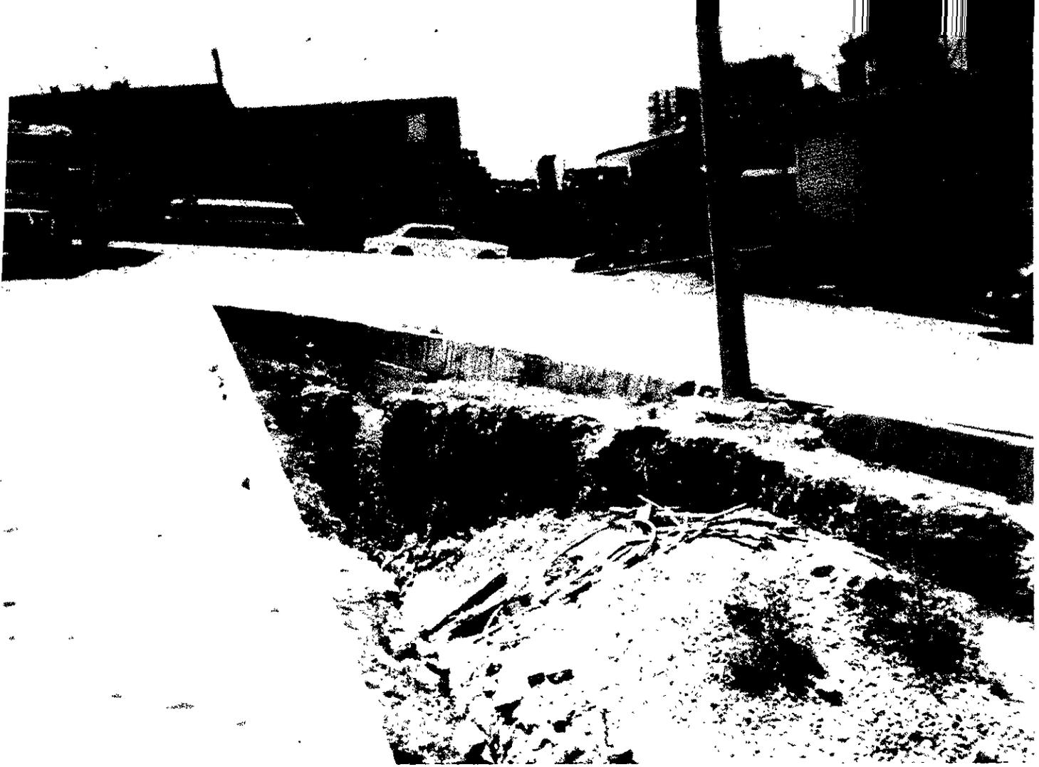
FIGURA 31.-Cabecera de un barranco secundario ubicado en una calle de la colonia La Unidad, la cual está situada en la ladera sur del barranco del Río Hondo, en Huixquilucan. En primer plano se aprecia la construcción de una guarnición de concreto, rodeada por un pavimento del mismo material que han impedido el avance de dicho barranco sobre la calle por efecto de la erosión remontante.
