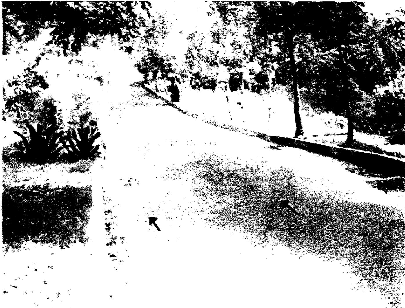
FIGURA 60.- Fotografía que muestra los agrietamientos sufridos en el coronamiento habilitado como puente de la presa de tierra que regula el caudal del Arroyo Dolores en la parte baja de la tercera sección del Bosque de Chapultepec (señalados con flechas). Al igual que en el caso anterior, dichas fracturas son producto de un proceso de reptación que está sufriendo el subsuelo debajo del extremo sur de la cortina
